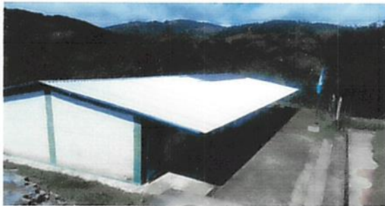
pintado de paredes y puertas del establecimiento ✓
