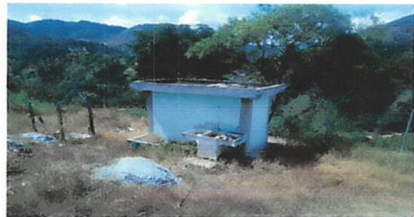
galera de la pila con su torta de cemento ✓
