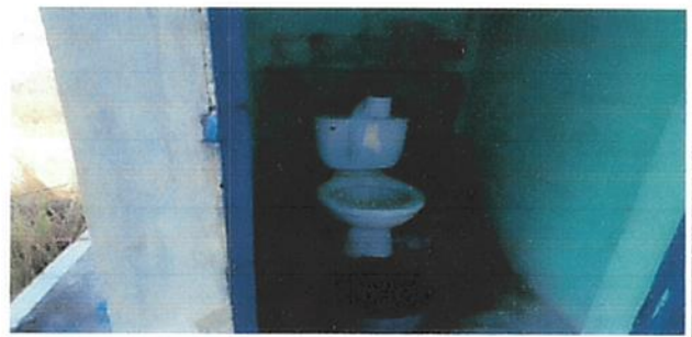
sustitucion de baños sanitarios ✓
