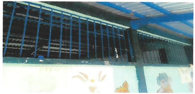
colocacion de ventanas con PVC ✓
