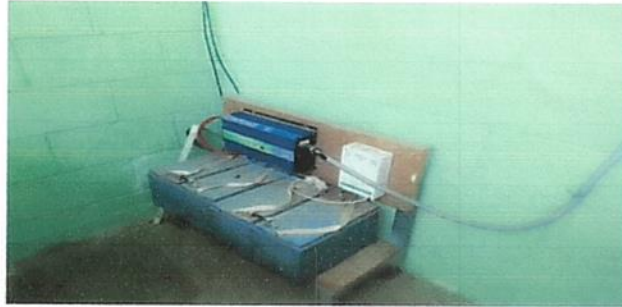
sustitucion de panel solares
